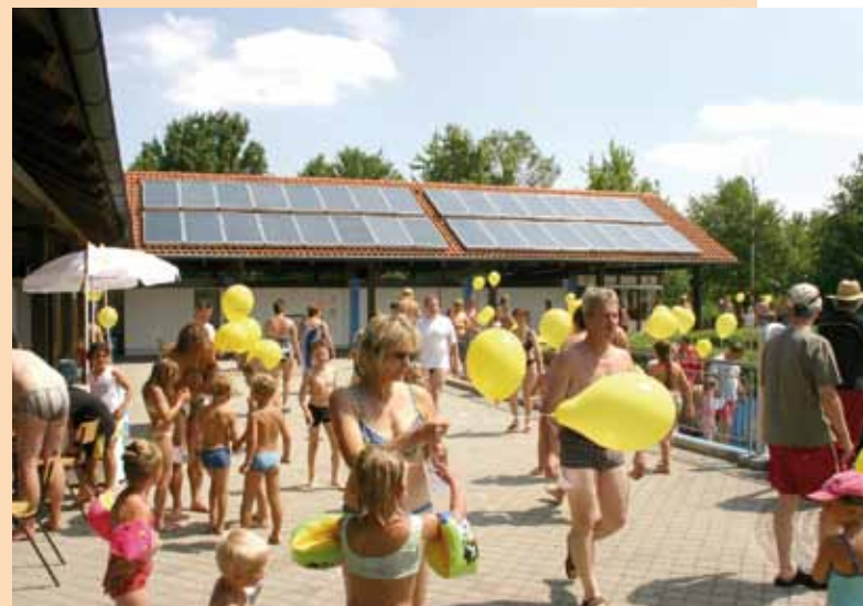
Erwärmung des Wassers mittels Solarkollektoren im Freibad Mammendorf, LK Fürstfeldbruck
