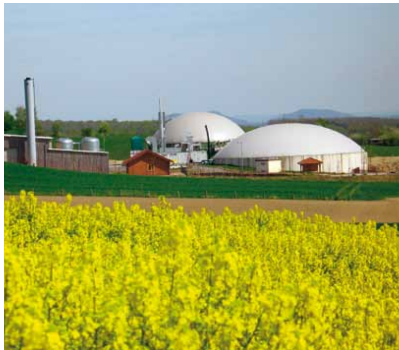
Bioenergieanlage im Bioenergiedorf Jühnde
